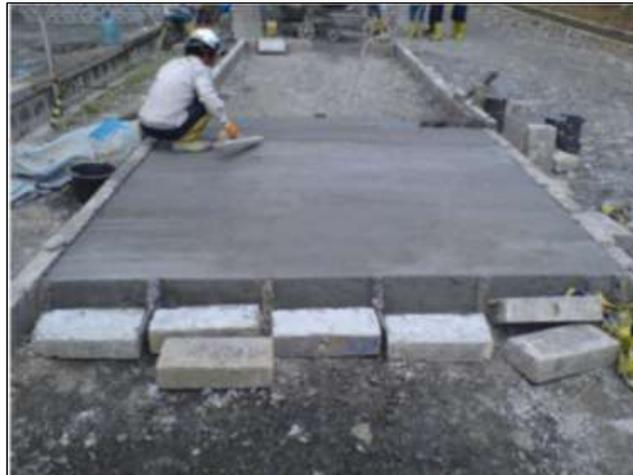
Gambar 7. Perataan Permukaan Jalan dan Sebagian Bekisting
